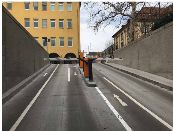
Bild 3 Rampe nach der Instandsetzungsmaßnahme mit Top12
