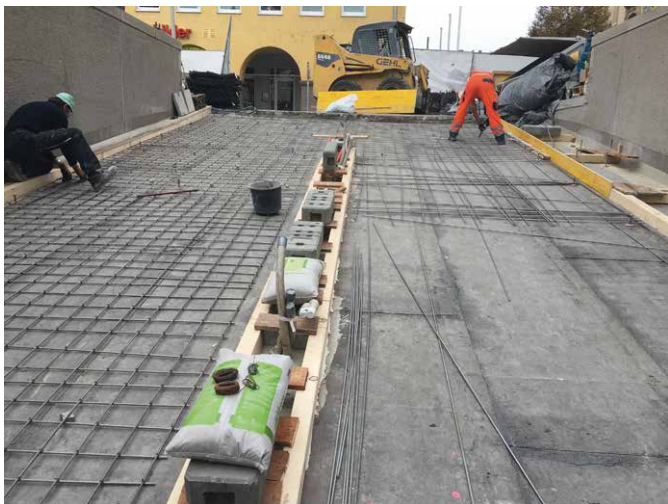
Bild 2 Instandsetzung einer Rampe mit Top12
